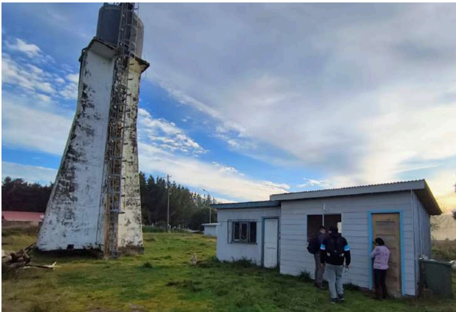
Visita a Terreno - Comunidad Caleta La Barra, Nueva Toltén, Araucanía
