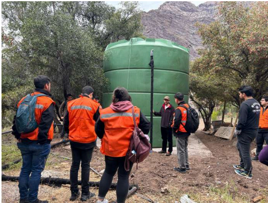
Estanque de 20 metros cúbicos para el sector Alfalfa Bajo
