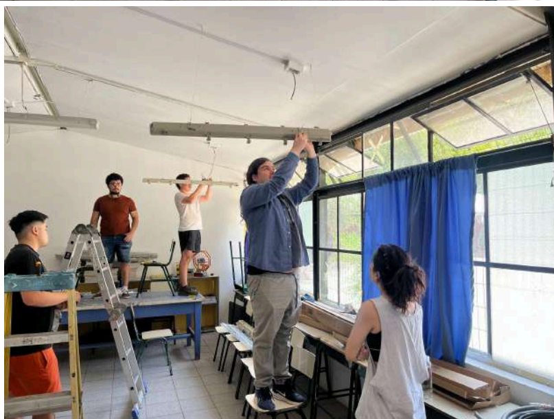
Instalación lana de vidrio y luminarias
