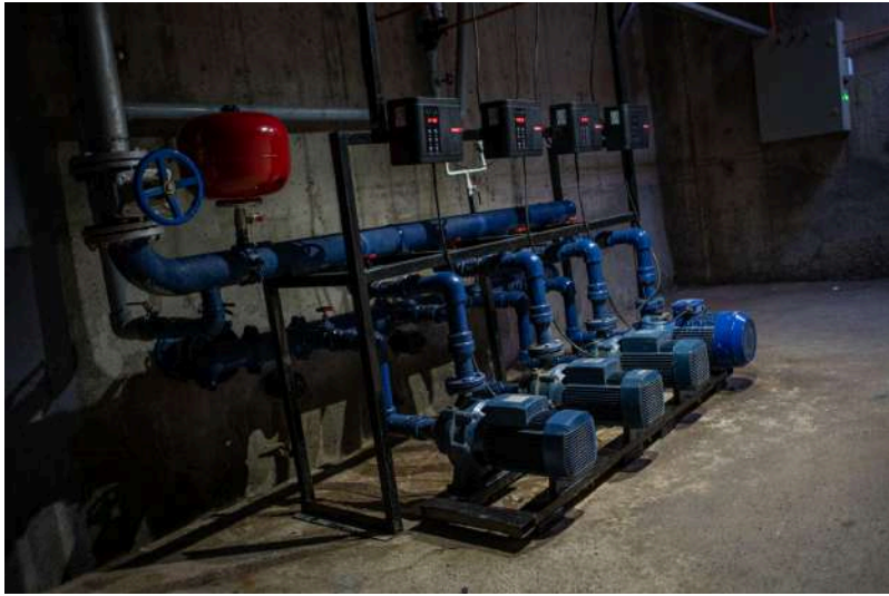
Sala de bombas reacondicionada
